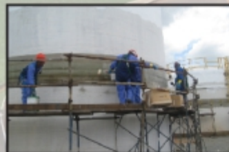
Laminação para união dos anéis
