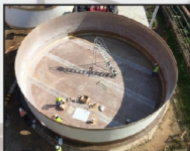
Unidos, os anéis são içados para posicionamento na base
