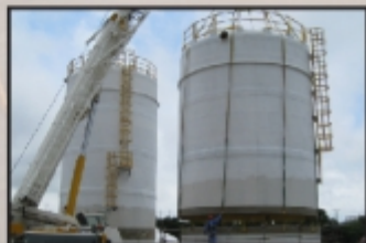
Unidos, os anéis são içados para posicionamento na base
